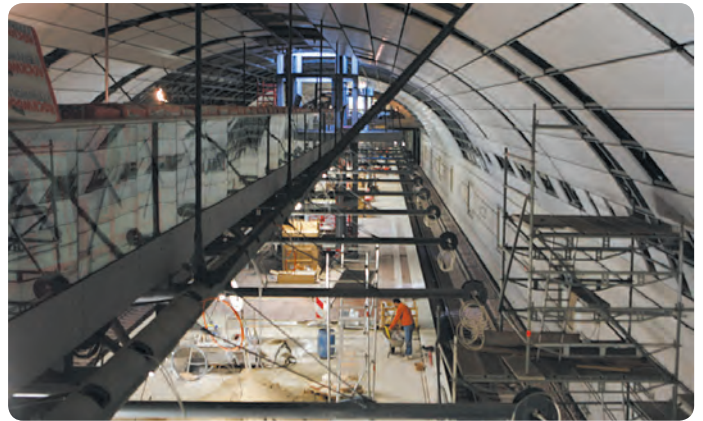
Baustelle der MEB GmbH.
