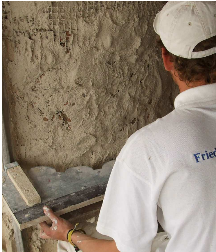
Stukkateur bei der Arbeit: Traditionelles Handwerk wird gepflegt.
