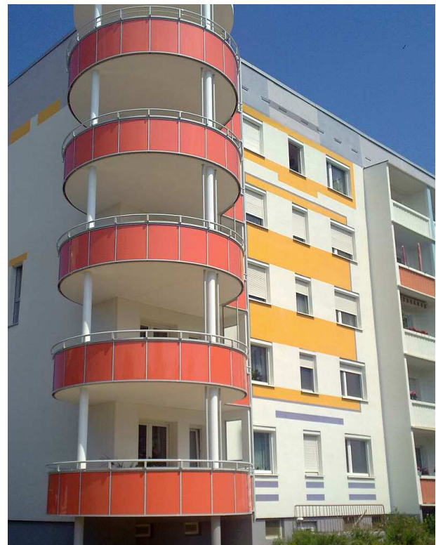
Moderne Balkonkonstruktion an einem Mehrgeschoss.
