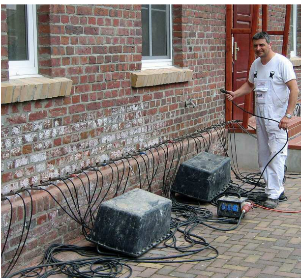
Innovatives Verfahren für trockene Fundamente.
