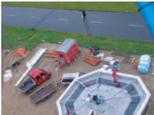
Towerbaustelle in Neubrandenburg.
