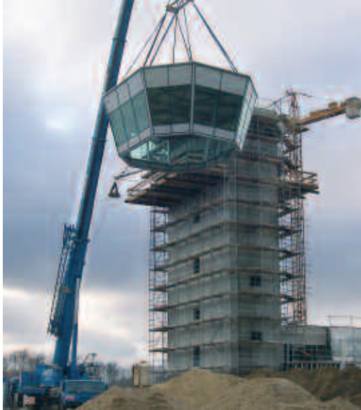
Die Kanzel wird auf den Tower gesetzt.
