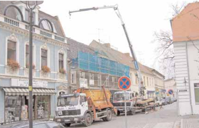
Dacharbeiten an einem Wohnhaus in Lübbenau
