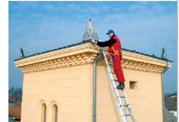
Reinigungsarbeiten in luftiger Höhe
